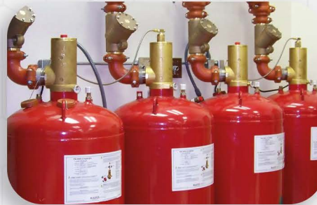
أنظمة الإطفاء بالغاز FM200 FM200 GAS EXTINGUISHING SYSTEMS
